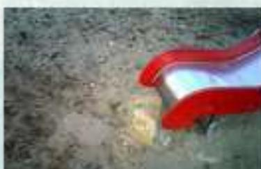
отсутствие демпфирования удара покрытием площадки (например, поверхность под горками, качелями вытоптана до твердого состояния)
