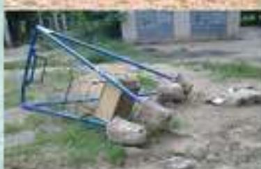
ненадлежащее закрепление элементов сооружений, опрокидывание которых может повлечь травмирование детей (например, незакрепленные теневые навесы, качели, перекладины, брусья)
